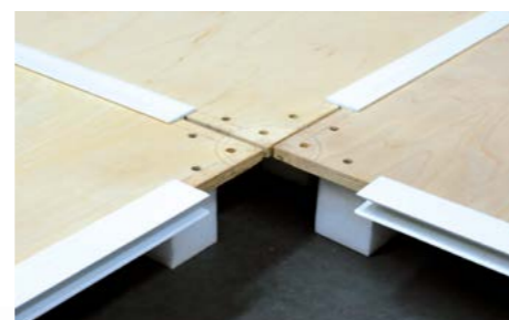
Schwingboden mit elastischen Schaumstoffblöcken.
